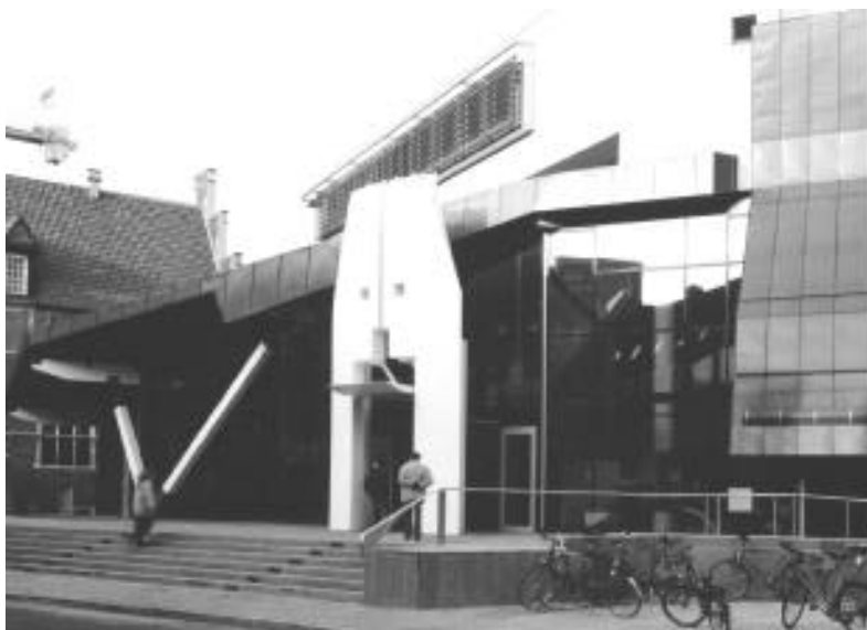
Abb. 3: Der Eingangsbereich (Foto: Landesbildstelle Westfalen)
