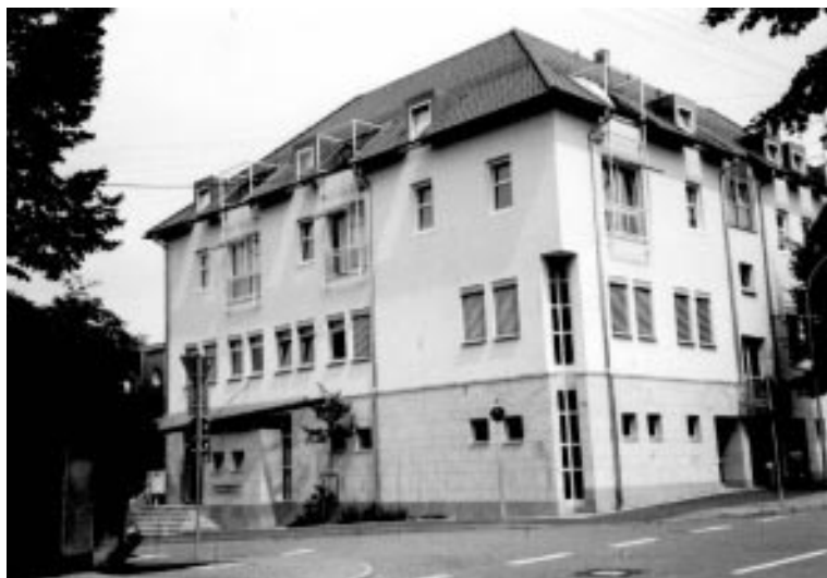
Abb. 1: Gesamtansicht: Über der Frankreich-Bibliothek in Erdgeschoss und im 1. Stock sind 8 Sozialwohnungen der Stadt untergebracht.
